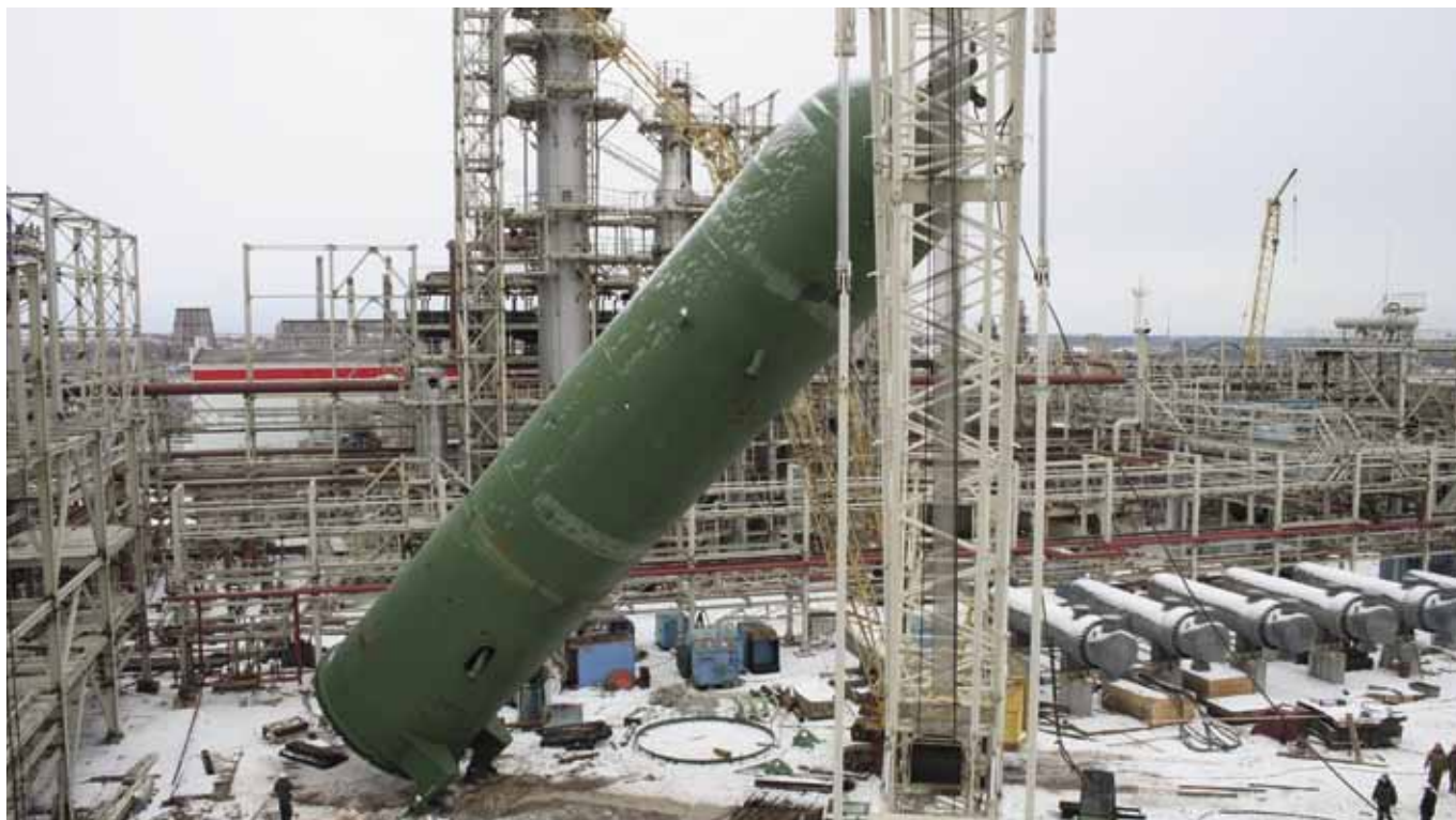
Монтаж реактора «Ижорских заводов» на площадке заказчика
